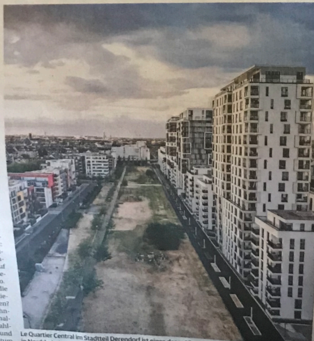
Le Quartier Central im Stadtteil Derendorf ist eines der größten städtebaulichen Entwicklungsprojekte in Nordrhein-Westfalen.
